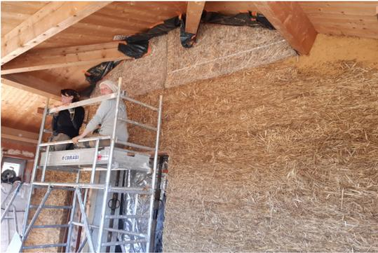
Test de pose des panneaux de paille
