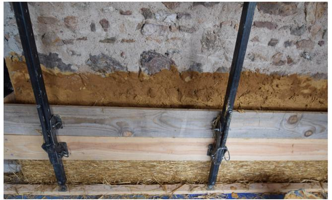
Système de banchage mis en place
