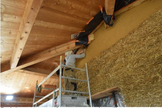
Enduit avant pose des panneaux de paille
