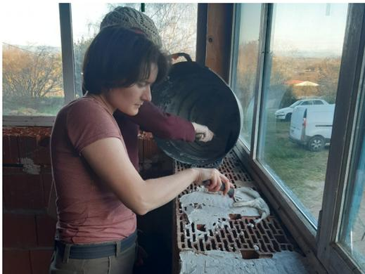
Travaux préalables dans le co-working, remplissage des briques avec du plâtre avant pose d'une tablette en bois
