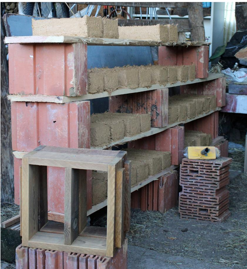
Installation des planches pour le séchage des adobes
