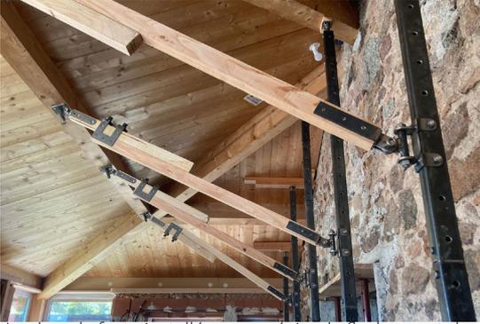
Jambes de force installées, pour éviter le flachement des montants
