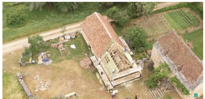
Figure 10 : Vidéo de chantier, Cours sur la tuile plate , Module « Comprendre »
